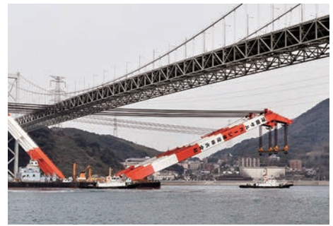
大型起重機船の曳航
